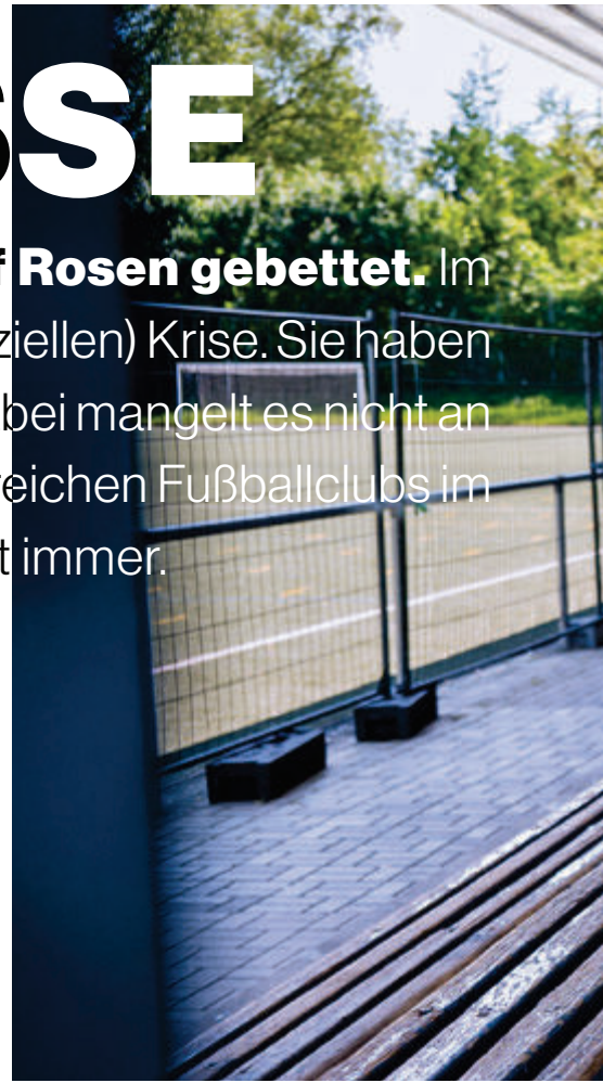
Die Tribüne des Sportplatzes Kaiserberg hat schon bessere Zeiten gesehen und soll abgerissen werden.
